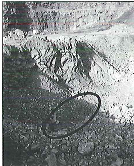
Fond de l'excavation : quelques eaux se sont accumulées suite aux dernières pluies puis rapidement infiltrées
